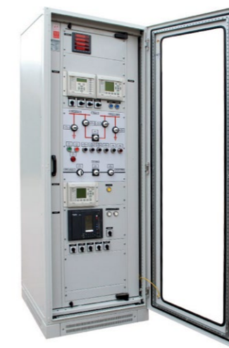
SON - Szafty oświetlenia ulicznego
